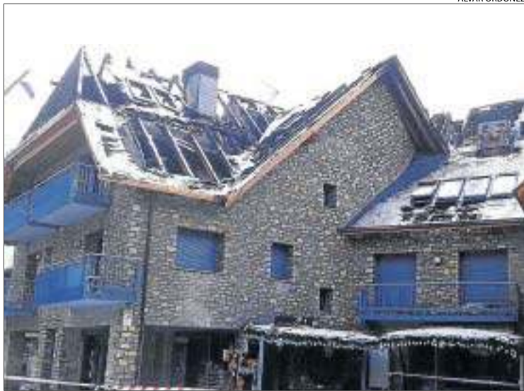
Les cases afectades presentaven ahir aquest aspecte.
