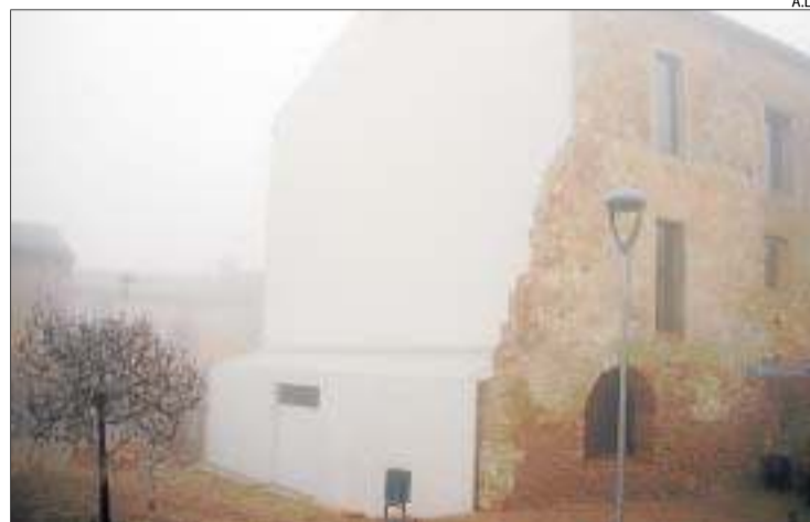
Vista del convent de la Granadella ja rehabilitat.
